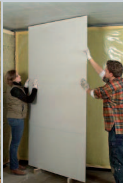
Gipsfaserplatten aufbringen – die Folie über der Dämmung dient als Dampfsperre
