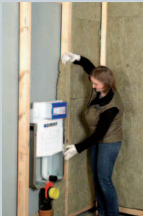
Füllen mit Dämm-Material - Installationssysteme sind leicht zu integrieren
