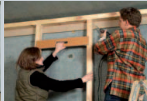
Aufschrauben der Unterkonstruktion
